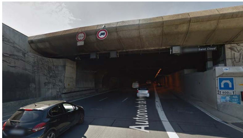
Autoroute A13 à Saint-Cloud : Elargissement après la bretelle d'insertion (voie d'insertion à droite)
