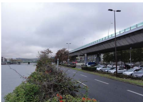
Quai existant (kilomètre sud du projet)
