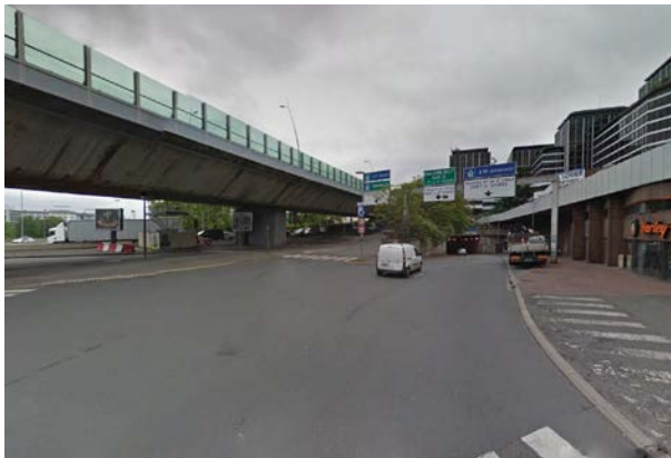
Place Georges Clémenceau – partie nord
