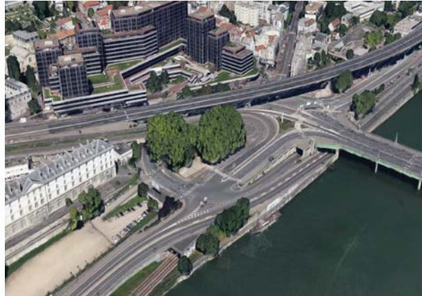
Place Georges Clémenceau actuellement (vue oblique Google Maps)
