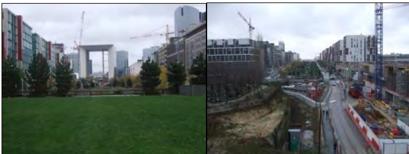
Figure 66 : Vue en direction de l'Arche vers l'est
