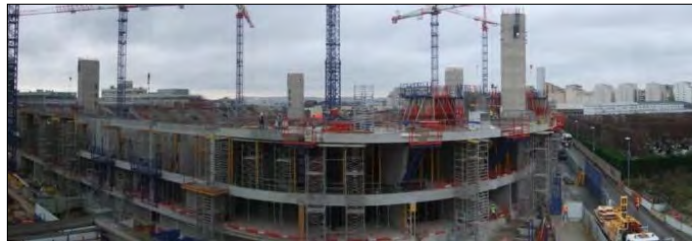
Figure 70 : Vue sur le chantier de l'Arena depuis la jetée Chemetov – Source : visite de terrain
