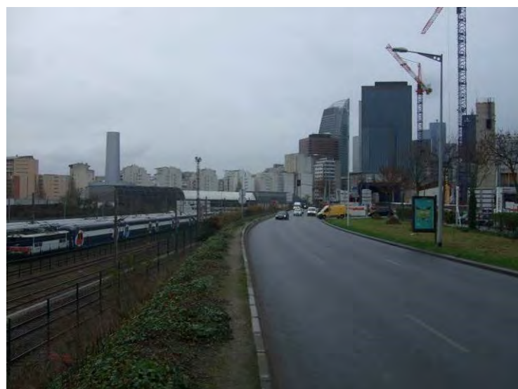
Figure 236 : Ambiance routière au droit du projet d'aménagement de la RD 914 et de la R 314
