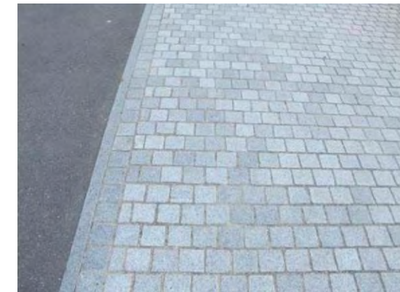
Figure 249 : Exemple de pavage
