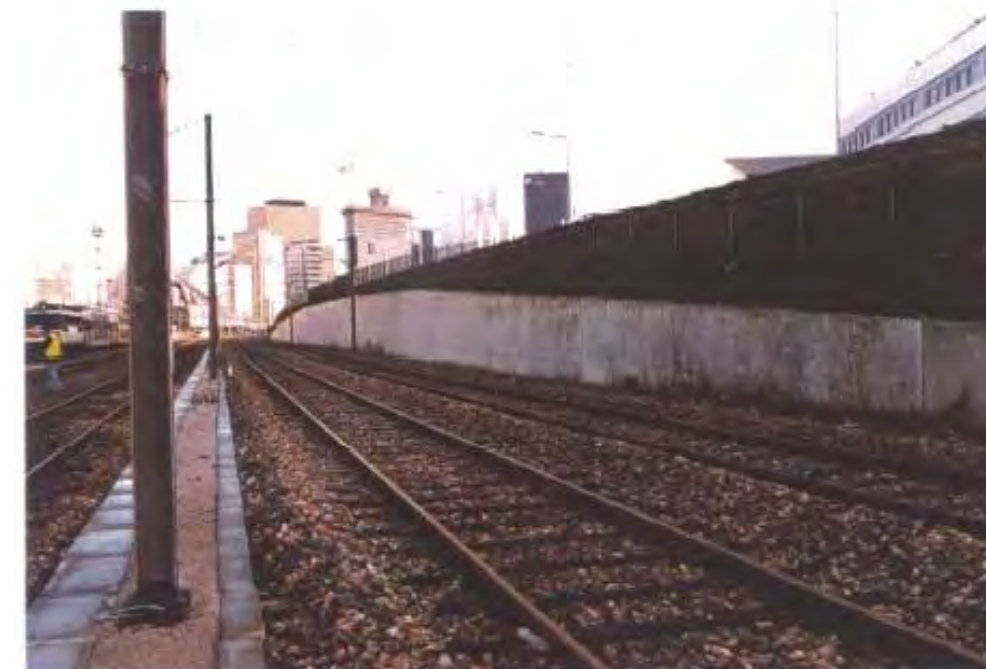
Figure 42 : Prise de vue du mur
