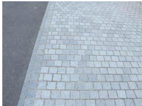
Figure 190 : Exemple de pavage
