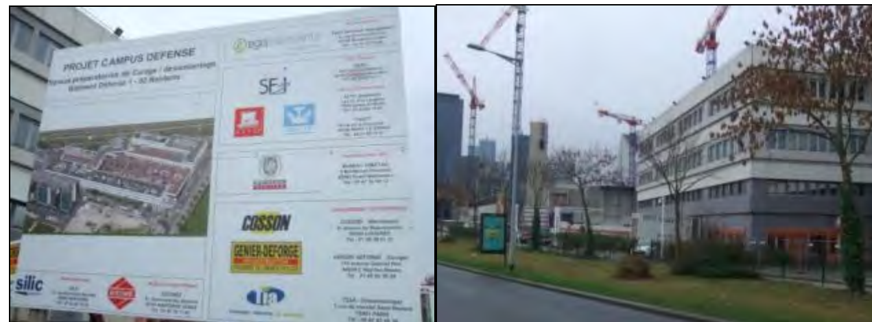
Figure 108 : Panneau d’information sur l’opération de curage-désamiantage des bâtiments à démolir au droit du futur projet Campus-Défense – Source : visite de terrain
