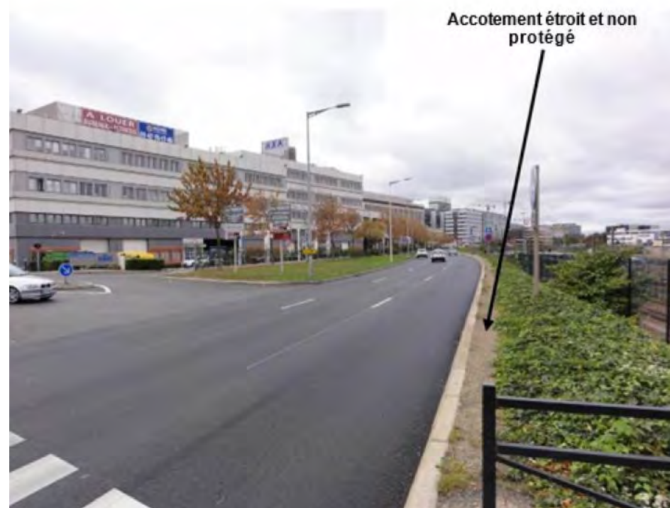
Photo 3 : la RD 914 au droit du croisement avec le boulevard Aimé Césaire
