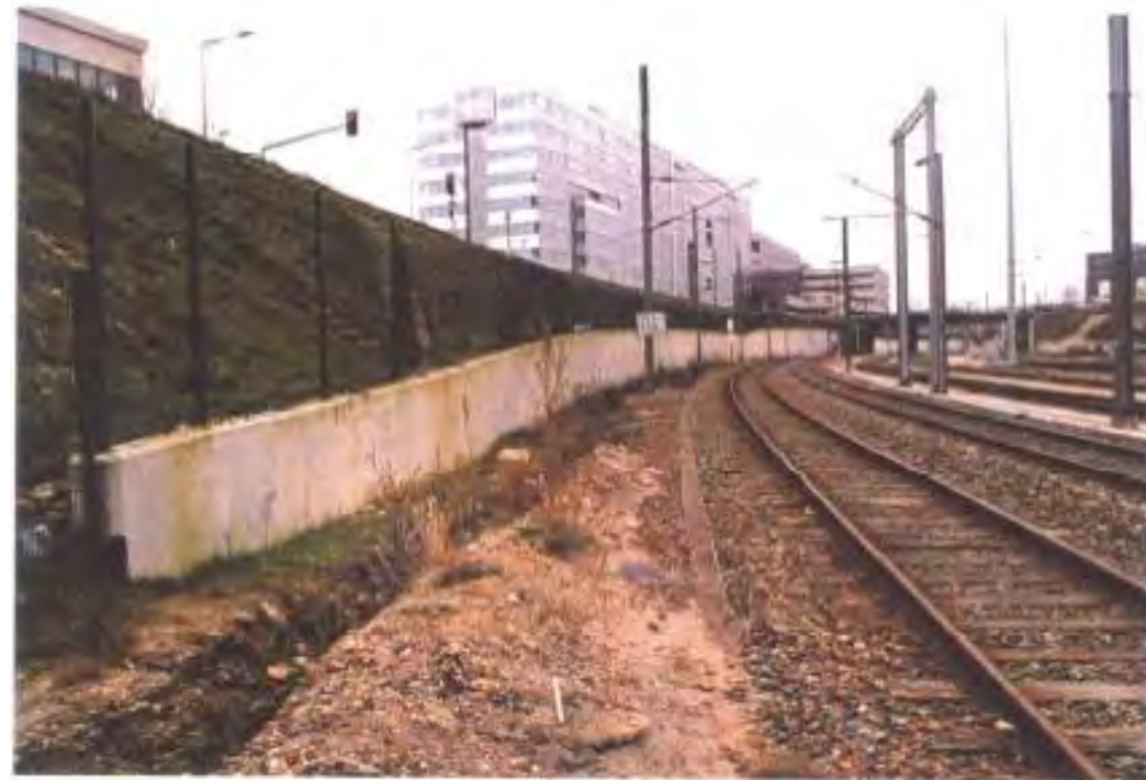
Figure 44 : Prise de vue du mur
