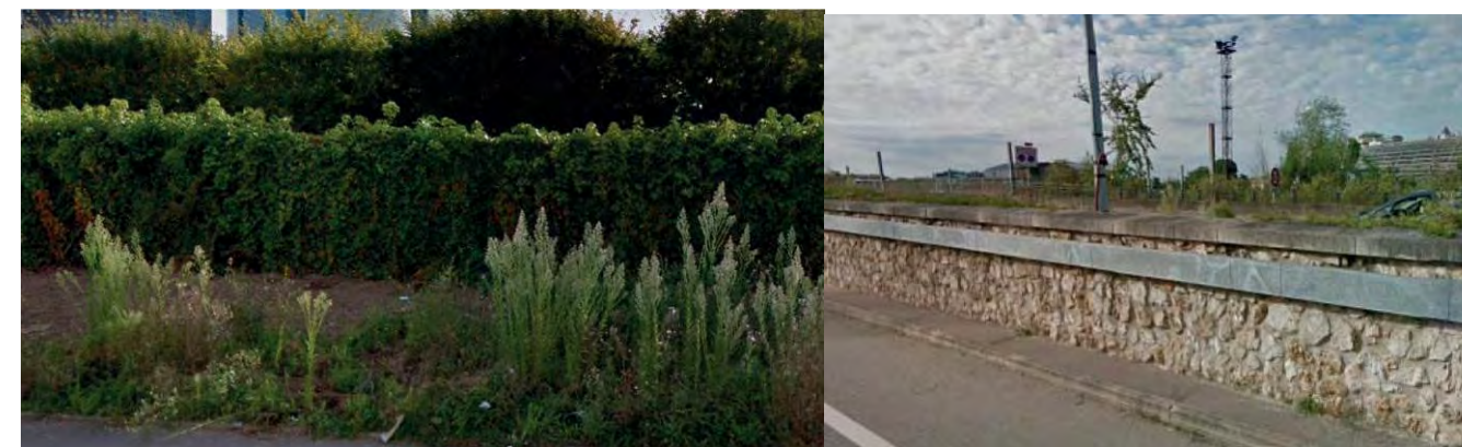
Figure 18 : Mur du cimetière végétalisé (Lierre) et exemple d'habillage en pierre (mur de la trémie de l'A 14)
