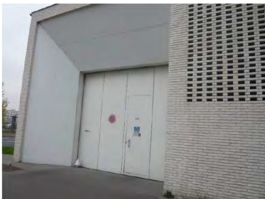
Figure 181 : Poste de redressement RATP
