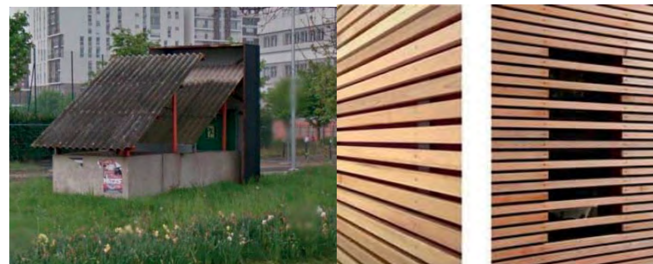
Figure 19 : Etat actuel de l'édicule de secours de l'A 14 et exemple de bardage en bois
