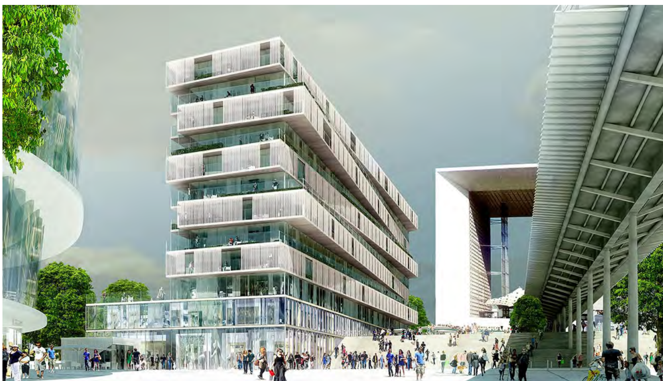
Figure 114 : Perspective sur l'immeuble One
