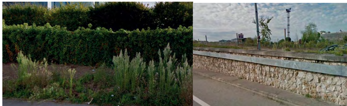
Figure 194 : Mur du cimetière végétalisé (Lierre) et exemple d'habillage en pierre (mur de la trémie de l'A 14)
