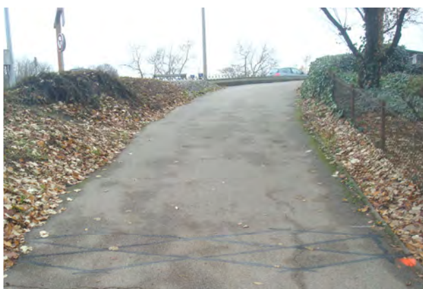
Figure 16 : compteur implanté sur le trottoir Sud de la RD910 Pont de Sèvres
