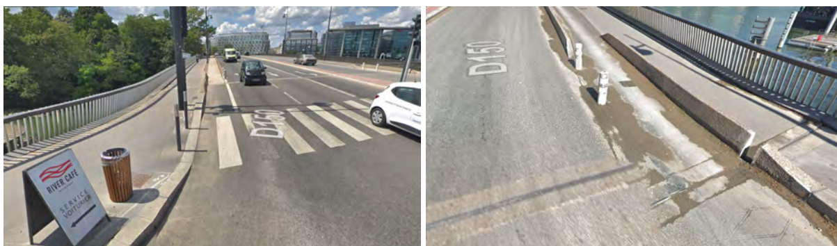
Figure 17 : compteurs implantés sur la RD50 Pont d'Issy côté Sud (à gauche) et côté Nord (à droite)
