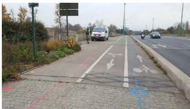
Figure 14 : compteur implanté sur le trottoir Nord de la RD3 Pont de Suresnes
