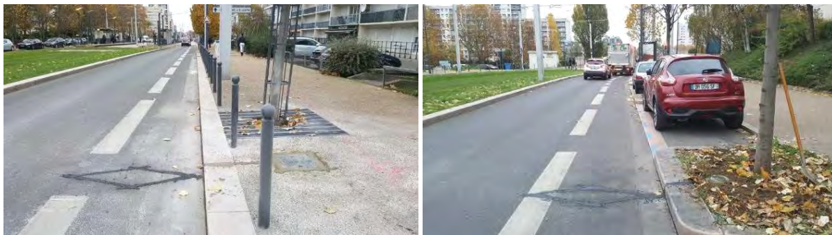
Figure 12 : compteurs implantés sur la RD986 à Villeneuve-la-Garenne côté Nord (à gauche) et côté Sud (à droite)
