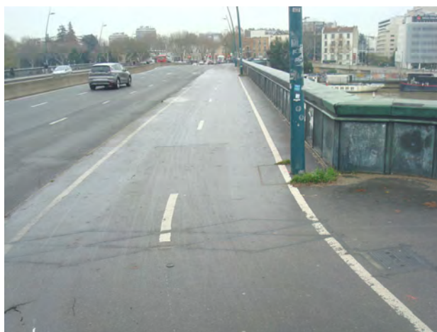
Figure 15 : compteur implanté sur le trottoir Sud de la RD907 Pont de Saint-Cloud
