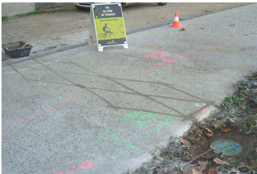
Figure 3 : exemple de dispositif sur une piste cyclable bidirectionnelle : 4 boucles et 1 boîtier enterré
