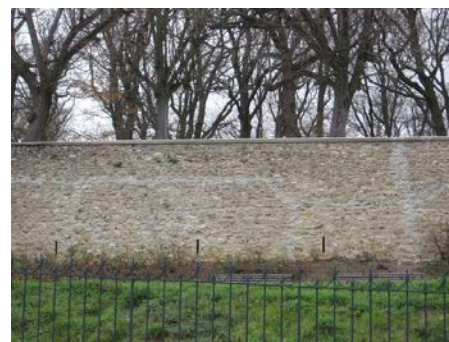
Travaux de réfection du mur en novembre et décembre 2011 / Fissure en cours de traitement / Mur assaini et fissures bouchées (©H.Pytlak).
