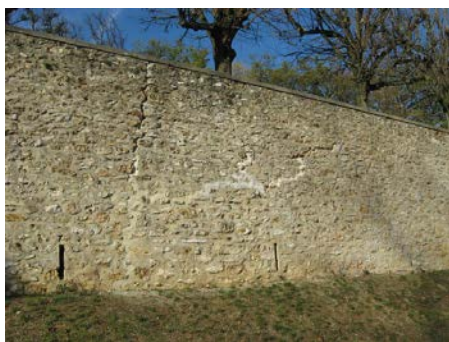
Travaux de réfection du mur en novembre et décembre 2011 / Fissure en cours de traitement / Mur assaini et fissures bouchées (©H.Pytlak).
